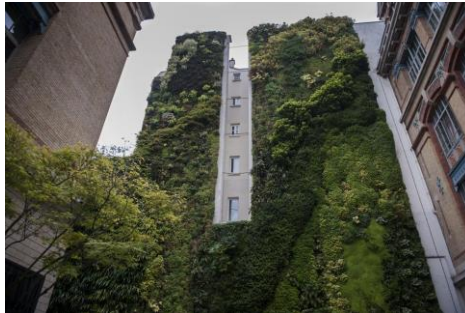
Mur végétalisé réalisé par le botaniste Patrick Blanc, près de la gare de l'Est, à Paris.
